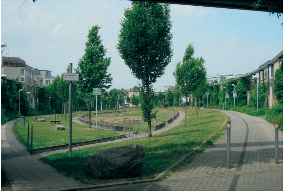
Abb. 72: Neubaugebiet mit integrierter Grünfläche zur besseren Regenwasseraufnahme
