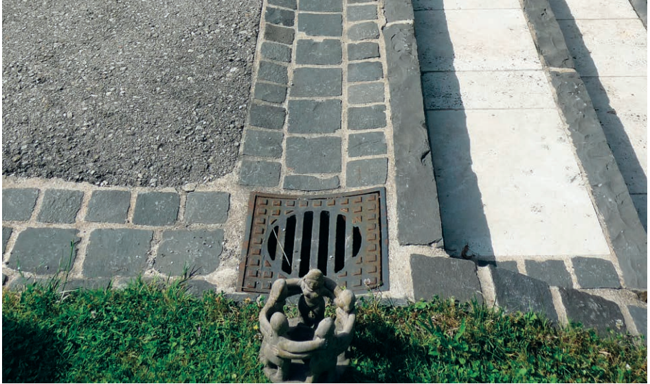
Abb. 90: Offene Mulden-Abflüsse und Aufkantungen an einem Hof halten das Wasser vom Haus fern.
