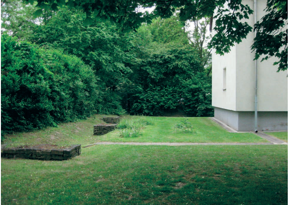
Abb. 93: Gartenanlage mit offenem Regenabfluss und Sickermulde
