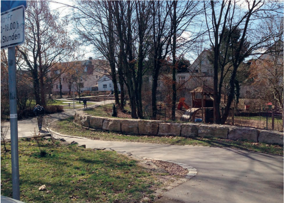
Abb. 120: Auch bei diesem Kindergarten in Ditzingen sind die Kosten des Hochwasserschutzes langfristig niedriger als die Kosten der Überflutungsschäden.
