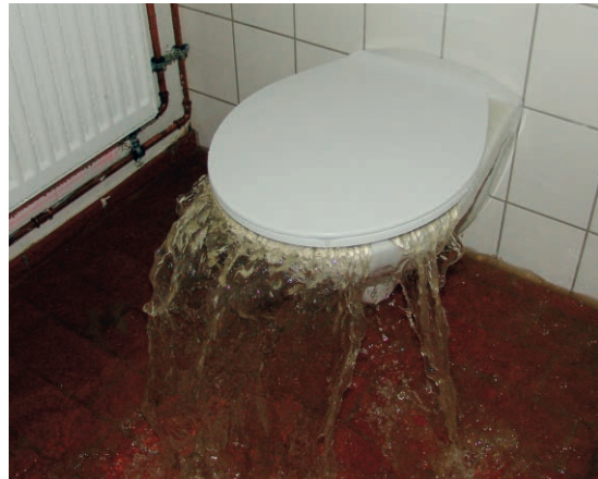
Abb.21: Überlaufende Toilette durch Kanalrückstau
