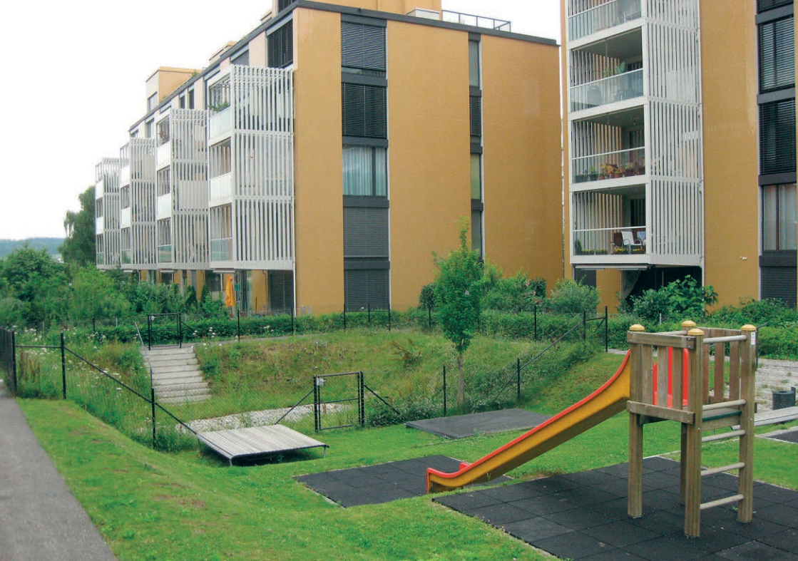
Abb. 119: Selbst die kleinste Fläche kann multifunktional als Spiel- und Sickerfläche genutzt werden.
