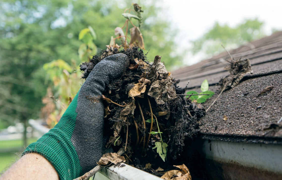
Abb. 22: Dachrinnen sollten immer frei durchlässig sein.
