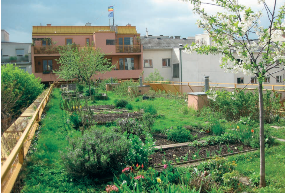
Abb. 91: Dachbegrünung auf einem Flachdach mit Obstbäumen, Blumen- und Gemüsebeeten
